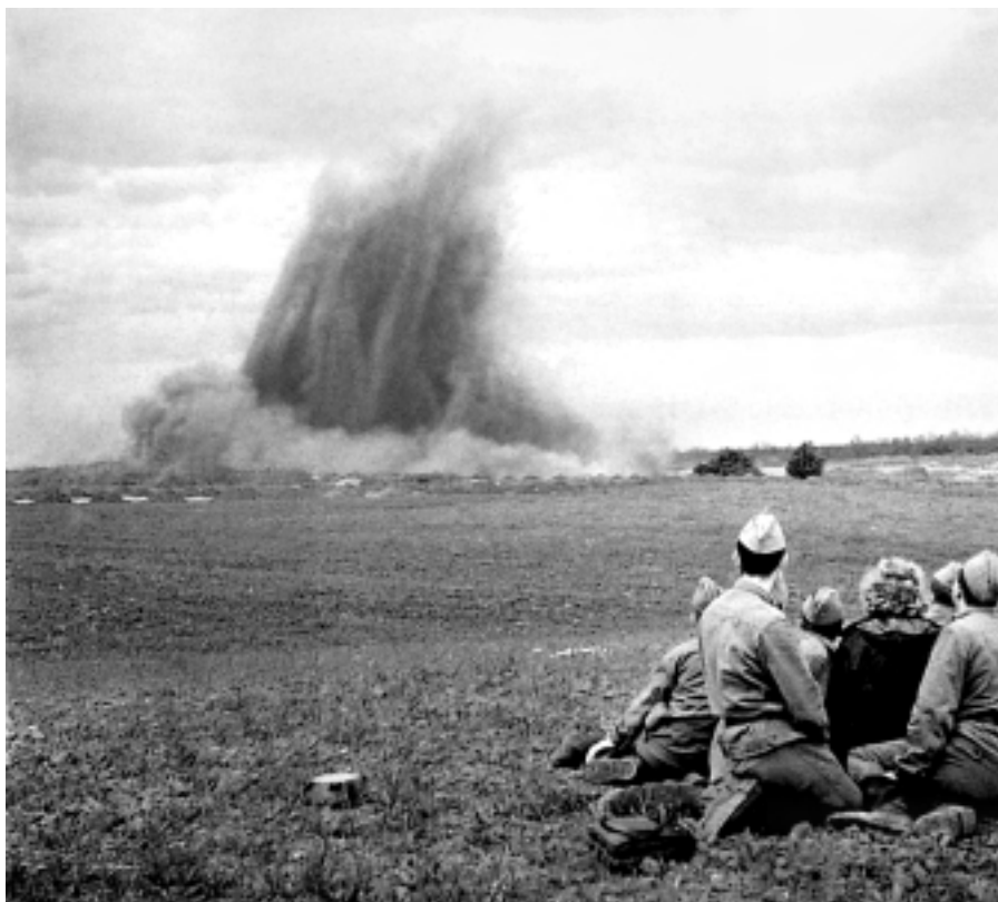
Взрывные работы на строительстве канала вблизи продолжающихся раскопок, 1974 г.
